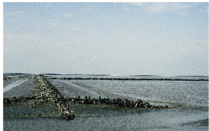
21 Strömungshindernisse zur Befestigung des Bodens im Wattenmeer bei Holward, Niederlande
