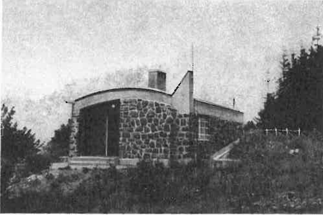
FIG. 8. Seismological station, Piskésetető
